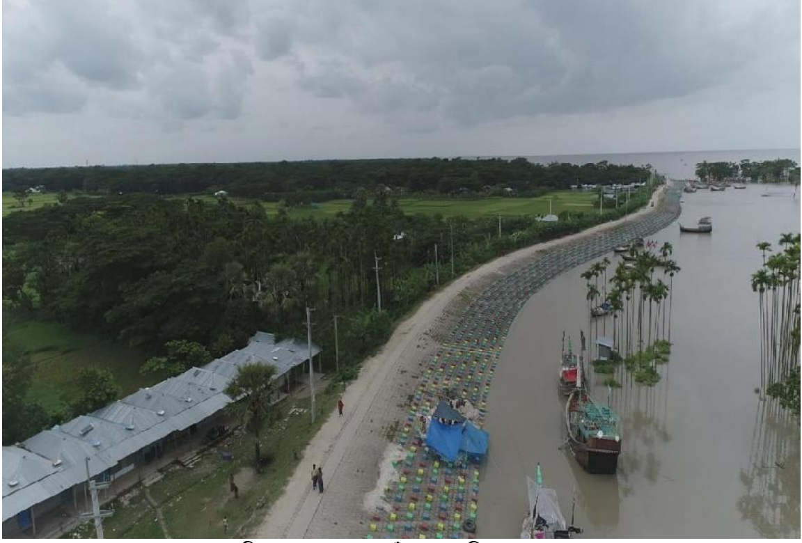
চিত্র: ঢাল সংরক্ষণসহ বাঁধ পুনরাকৃতিকরণ কাজ।
