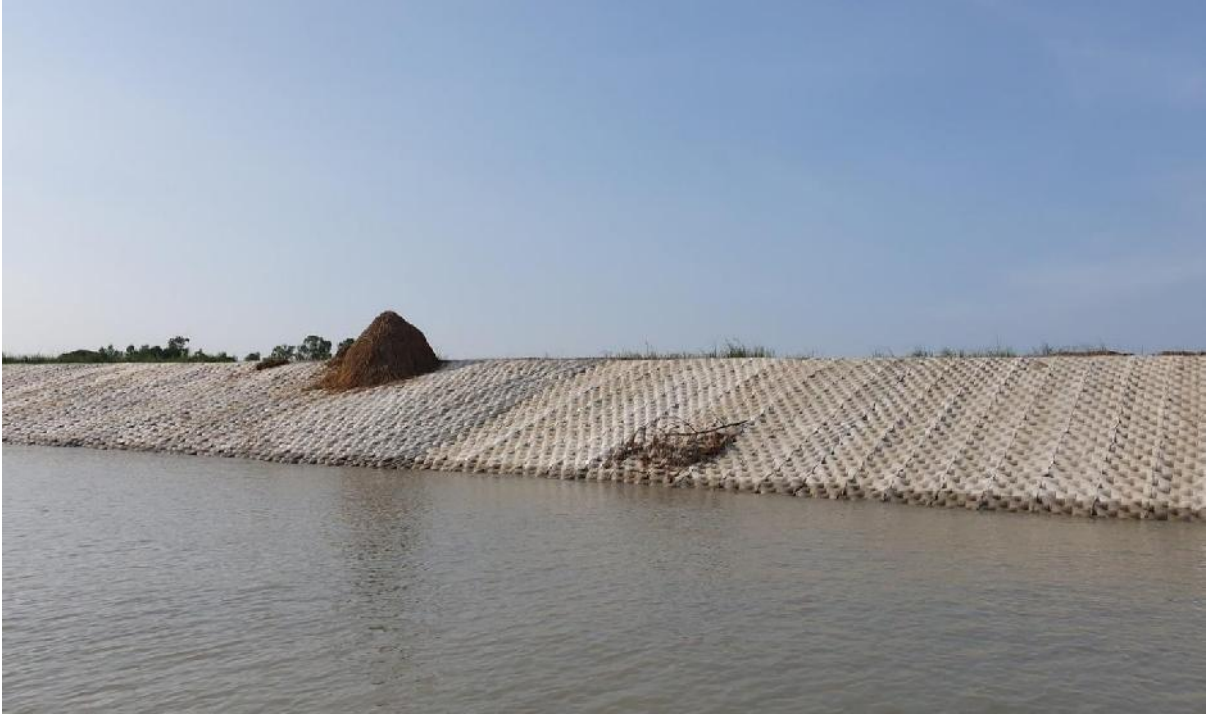
Grout Filled Jute Mattress প্রযুক্তি ব্যবহার করে বাঁধের ঢাল সংরক্ষণ কাজ
