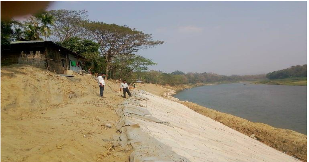
নদী তীর রক্ষা কাজ (চলমান) শঞ্খেরকুল-রেইকঘাটা : ৩৫০ মিটার
