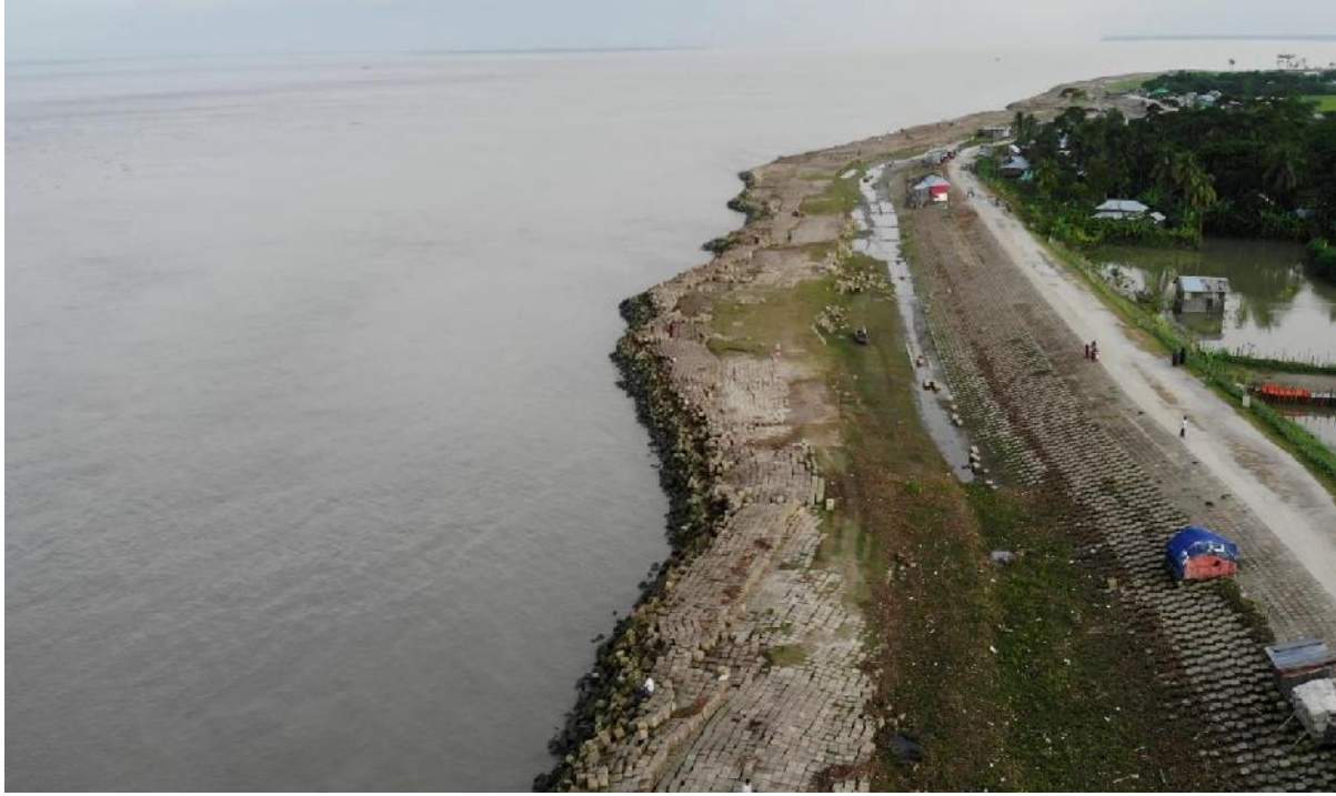
বাস্তবায়িত বাঁধের ঢাল প্রতিরক্ষা ও নদী তীর সংরক্ষণ কাজ
