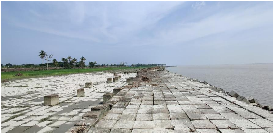
প্রকল্পে সম্পাদিত নদী তীর সংরক্ষণ কাজ
