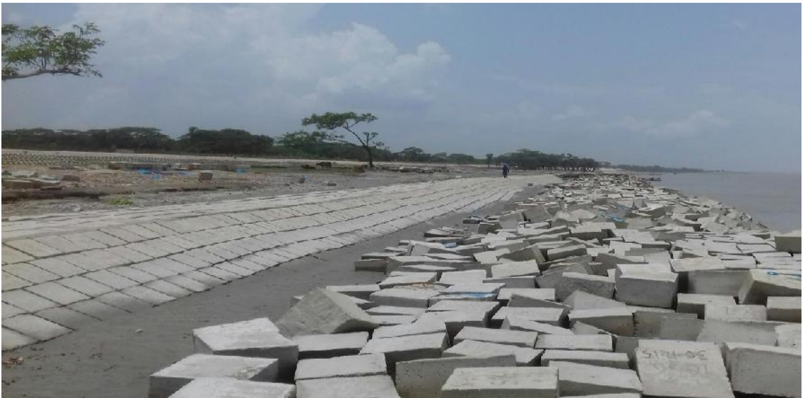
রামনেওয়াজ লঞ্চঘাট (মনপুরা) এলাকায় সম্পাদিত নদী তীর সংরক্ষণ কাজ
