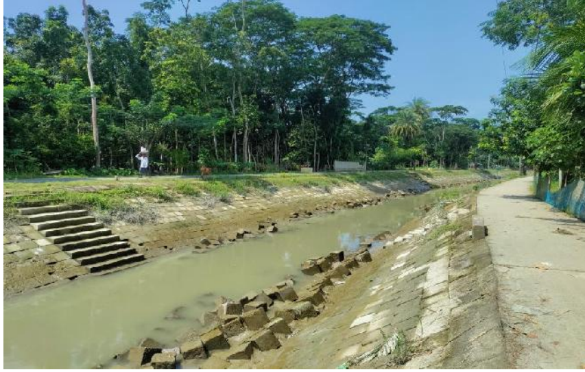
প্রকল্পে সম্পাদিত স্থায়ী তীর প্রতিরক্ষা কাজ
