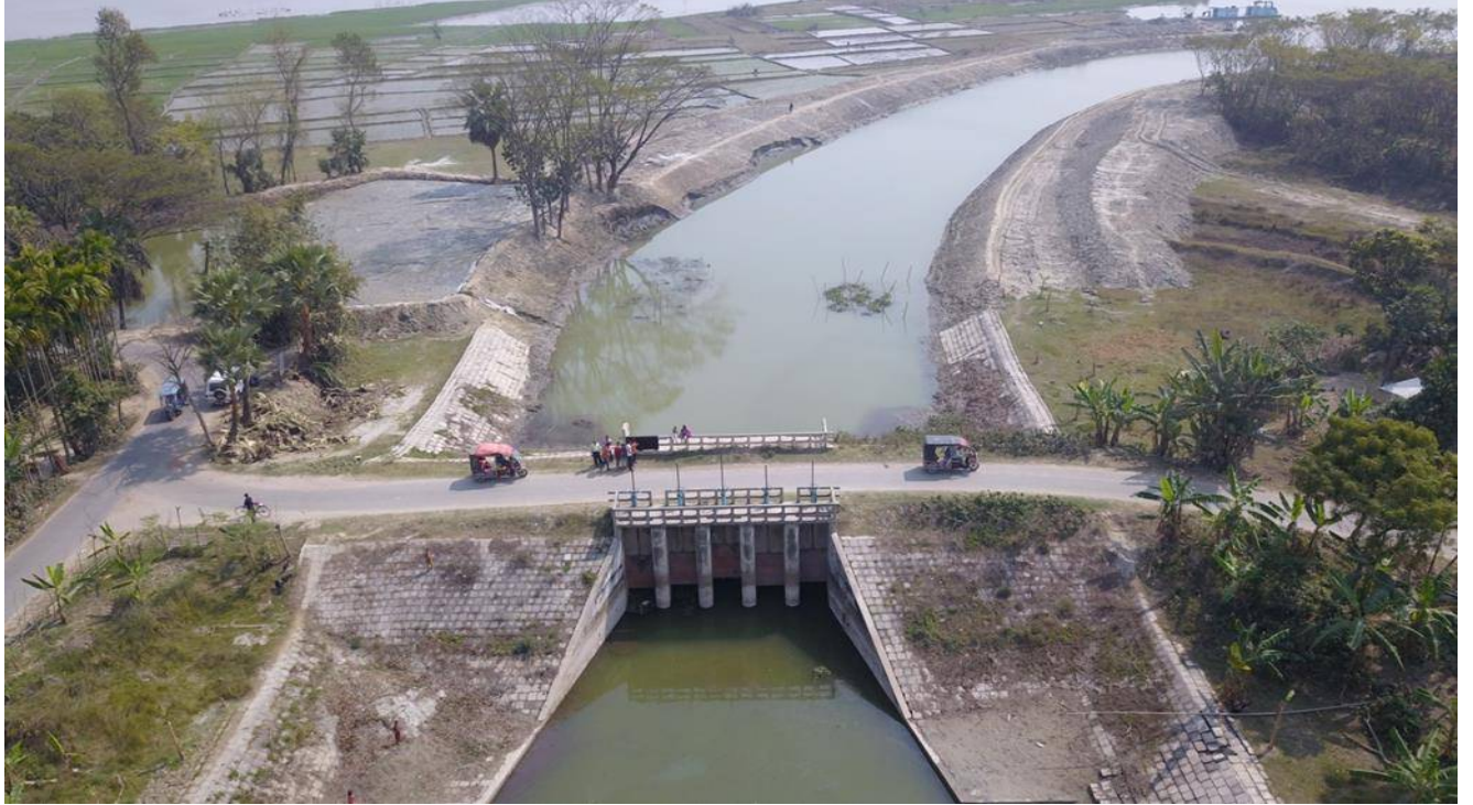
নড়াইল জেলার চাপাইল নামক স্থানে খননকৃত আঠারোবাঁকী নদীর উপর নির্মিত ৫-ভেন্ট চাপাইল স্টুইস
