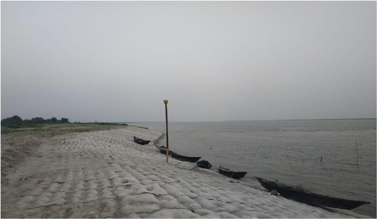
মানিকগঞ্জ জেলার হরিরামপুর উপজেলায় Grout Filled Jute Mattress প্রযুক্তি ব্যবহার করে ৮.৮০ কিঃমিঃ পদ্মা নদীর তীর সংরক্ষণ কাজ
