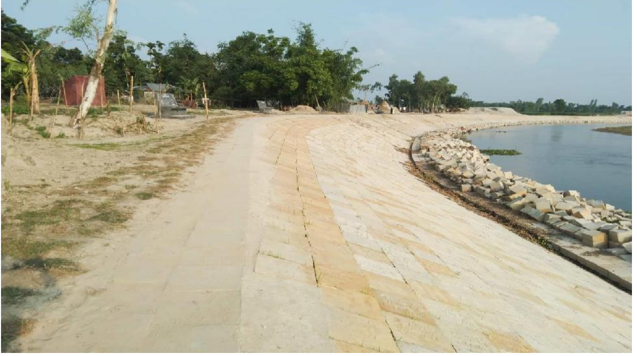
বাস্তুবায়িত নদী তীর প্রতিরক্ষা কাজ; স্থান- মনমস্বকুটিরপাড়া, রংপুর
