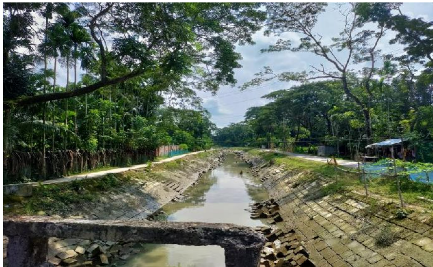
প্রকল্পে সম্পাদিত স্থায়ী তীর প্রতিরক্ষা কাজ
