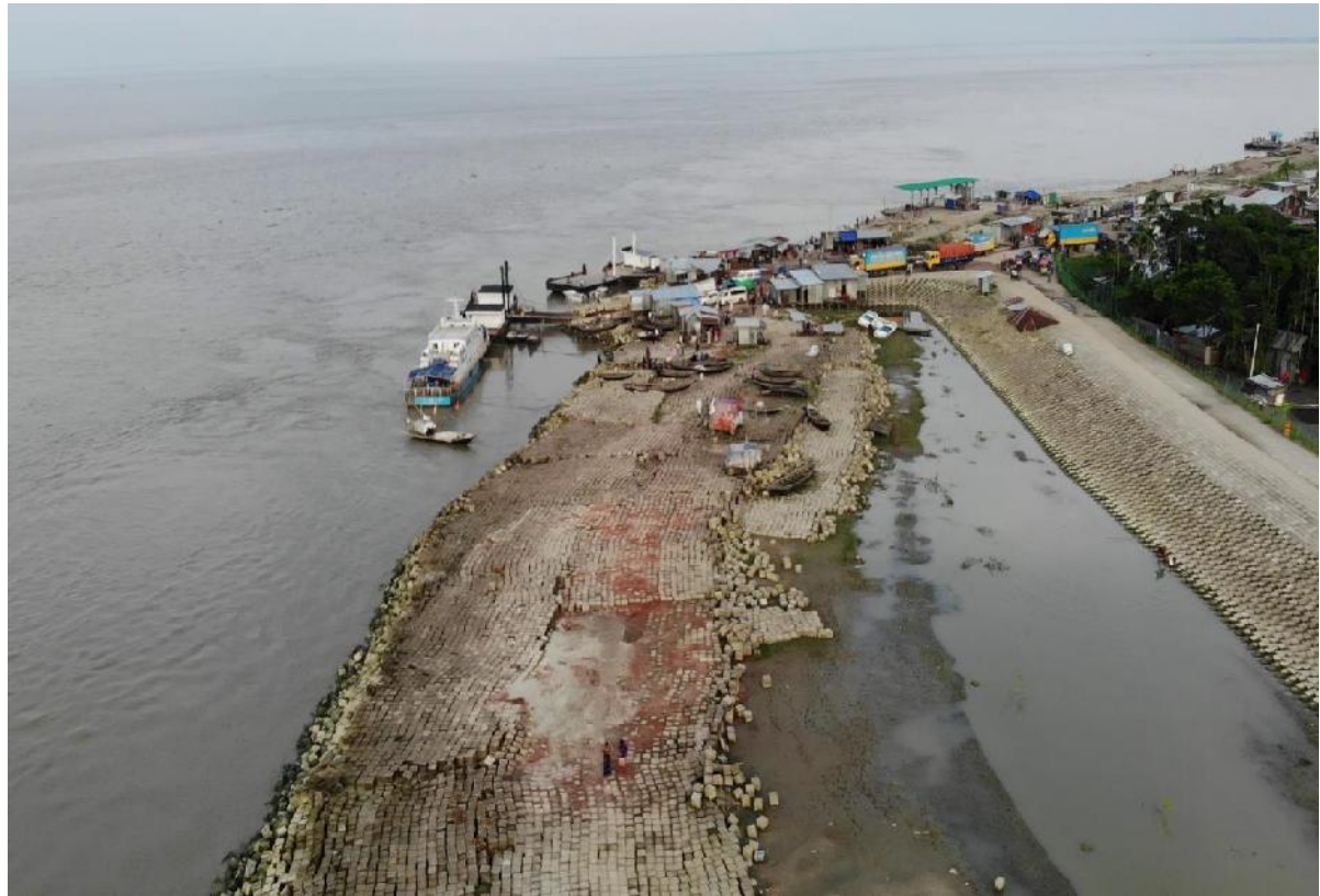
বাস্তবায়িত বাঁধের ঢাল প্রতিরক্ষা ও নদী তীর সংরক্ষণ কাজ
