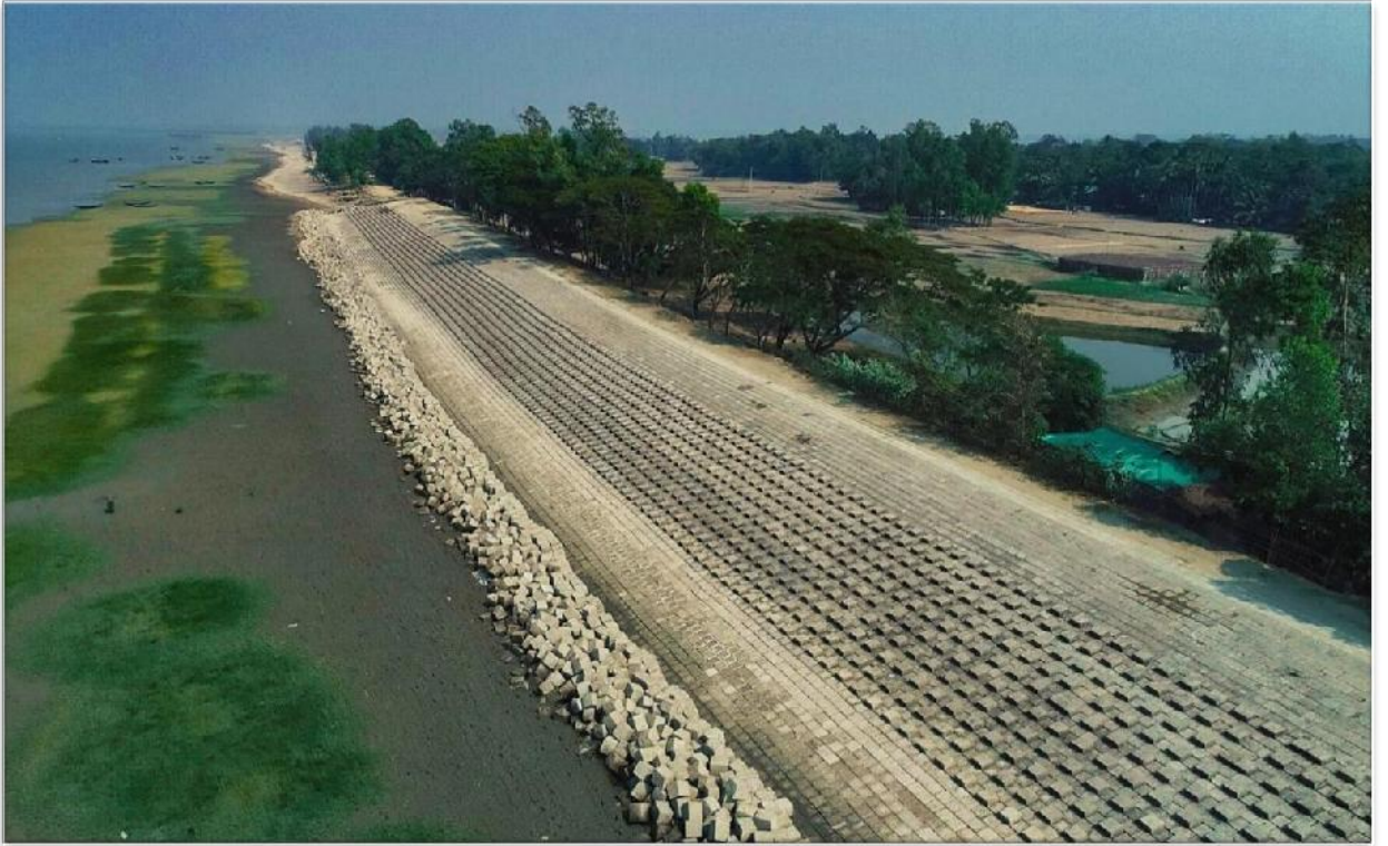
কক্সবাজার জেলার খুরুশকুলে পোল্ডার ৬৬/১ এ বাস্তবায়িত তীর প্রতিরক্ষা কাজ
