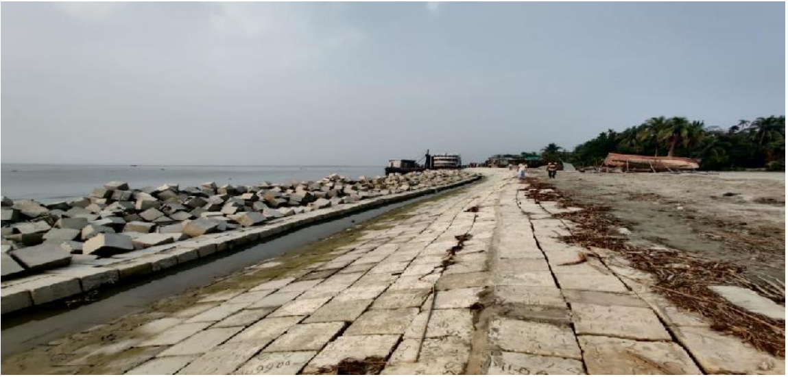
ঘোষের হাট লঞ্চঘাট (চরফ্যাশন) এলাকায় সম্পাদিত নদী তীর সংরক্ষণ কাজ
