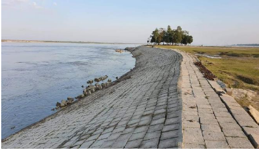
প্রকল্পে সম্পাদিত স্থায়ী নদী তীর সংরক্ষণ কাজ
