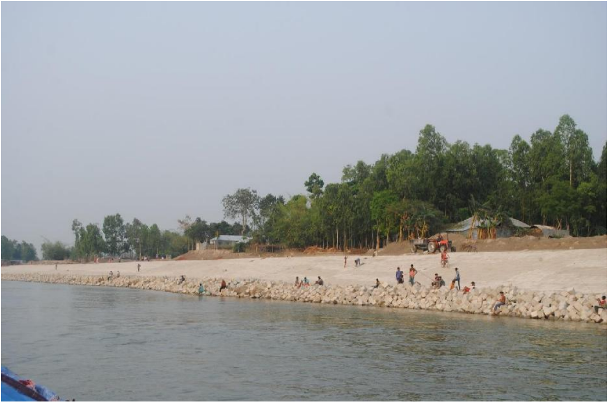
সিরাজগঞ্জ জেলার চৌহালী উপজেলায় সম্পাদিত ৭.০০ কিঃমিঃ যমুনা নদীর তীর সংরক্ষণ কাজ
