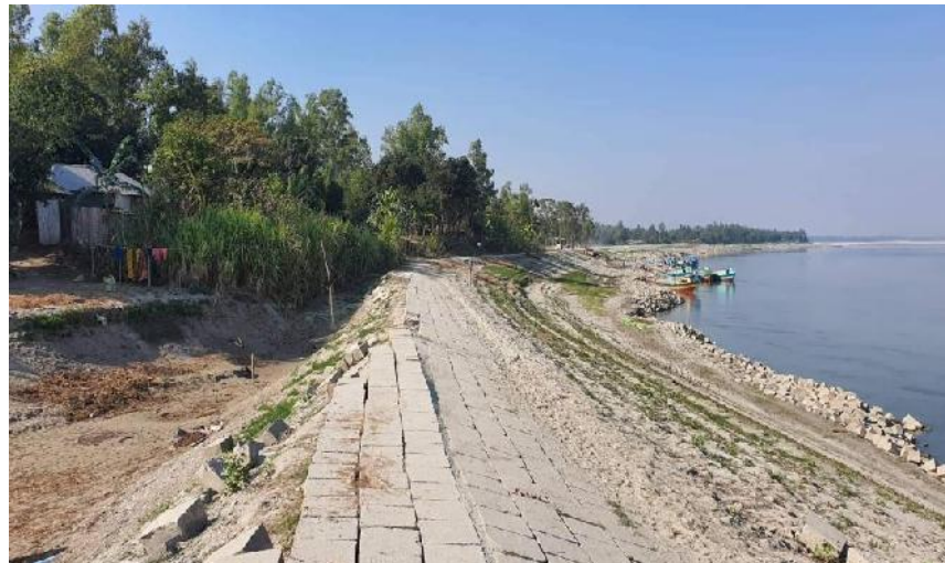
প্রকল্পে সম্পাদিত স্থায়ী নদী তীর সংরক্ষণ কাজ
