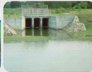
রংপুর খালের অতিরিক্ত পানি নির্গমন কাঠামো Escape Over Rangpur Canal
