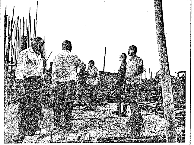
স্লুইস নির্মাণ কাজ পরিদর্শনের স্থির চিত্র।
