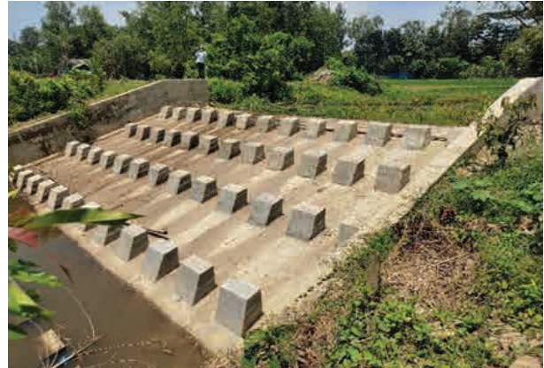
Figure 3: মরাছড়া খালে Baffled Apron drop
