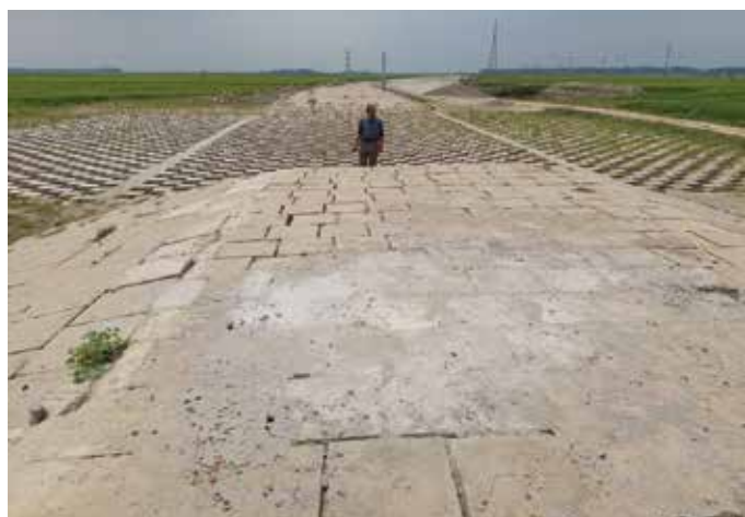
চিত্র-২: ২০২১-২২ অর্থ বছরে নির্মাণাধীন কালীন চিত্র (Base এ এবং Slope এ CC Block স্থাপনের কাজ সম্পন্ন), কিশোরগঞ্জ, নওগাঁ হাওর পার্ট-বি।
